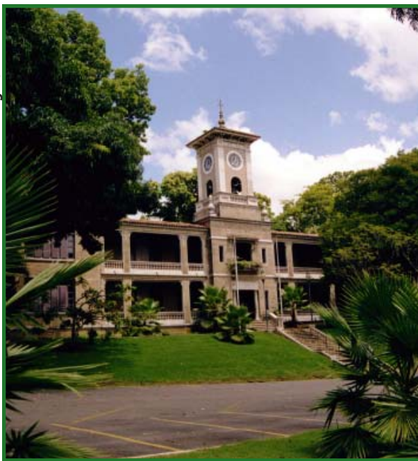
Primer plano del Edificio José de Diego.
